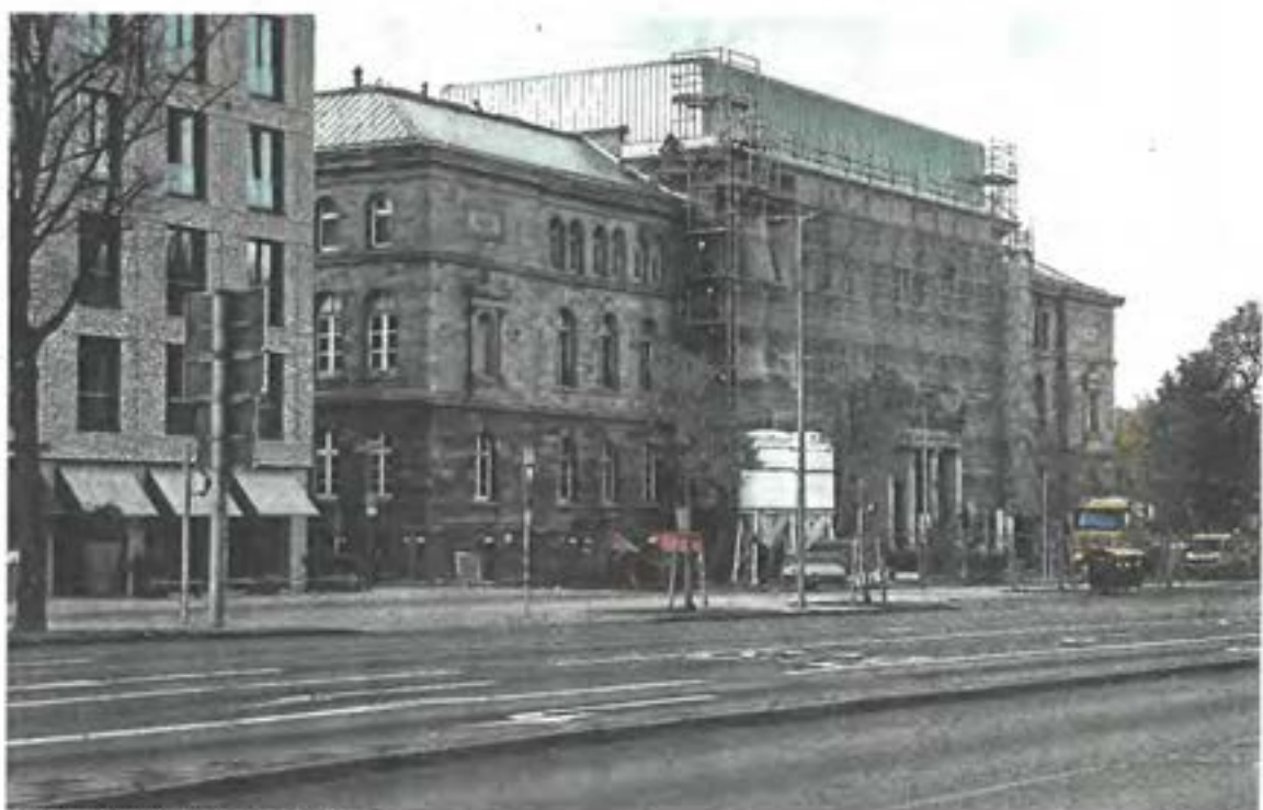
Baustelle „Forum Wissen“ an der Berliner Straße.
