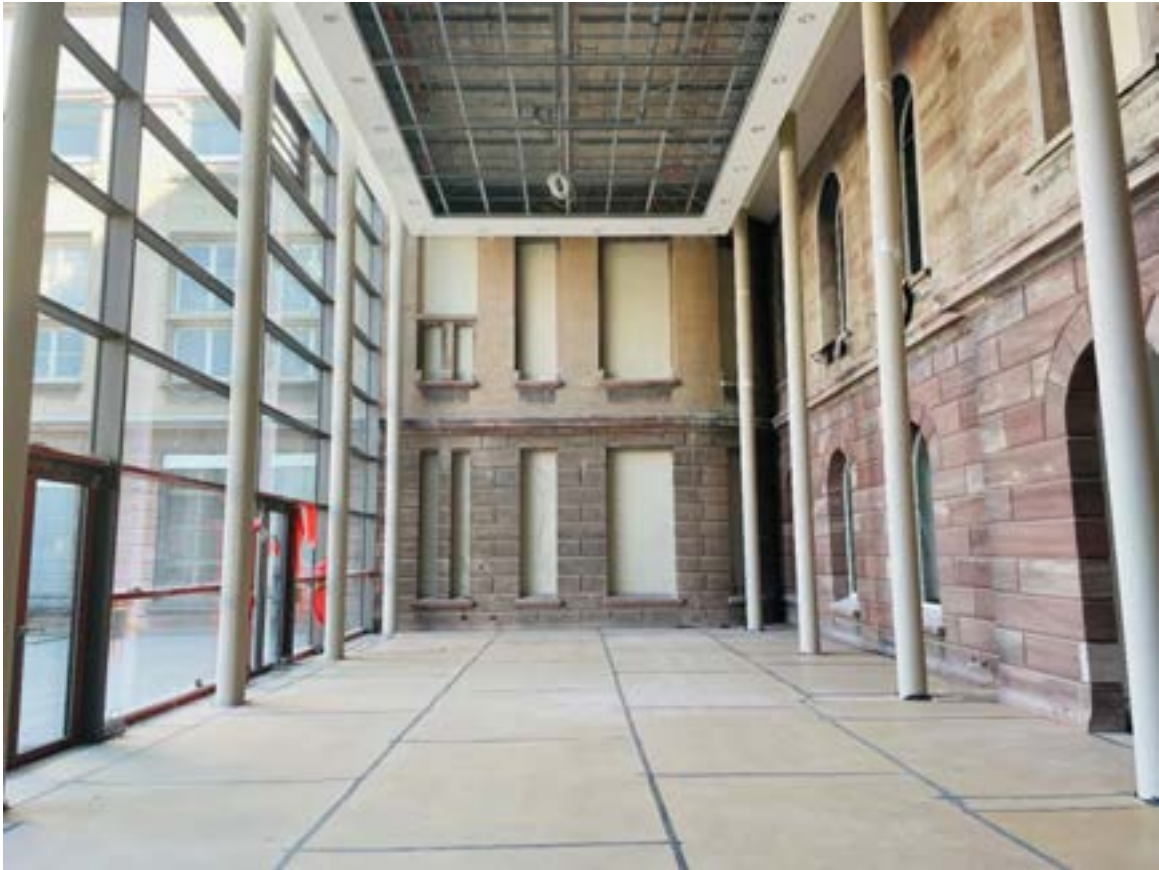
Atrium im Erdgeschoss
