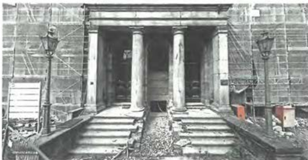
Die Arbeiten am „Forum Wissen“ der Universität Göttingen schreiten voran: Nicht allen gefällt das. Der Geschichtsverein Göttingen hat erneut die „Zerstörung“ des Eingangsportals des denkmalgeschützten Gebäudes kritisiert. FOTO: RICHTER
