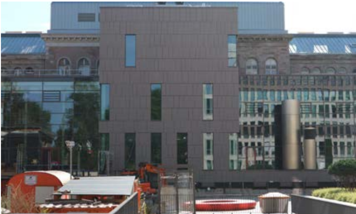
Neubauten auf der Westseite
